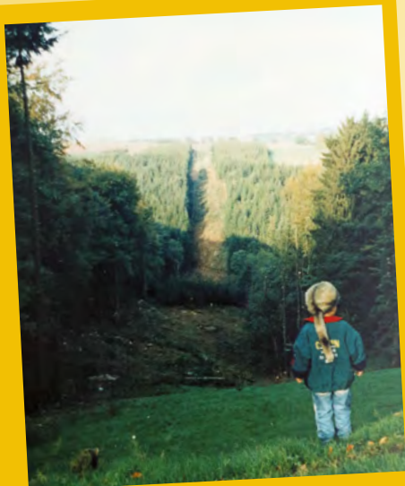
1995 : Ligne HTA - Mittelbronn : Création d'une tranchée de + de 500 mètres.
